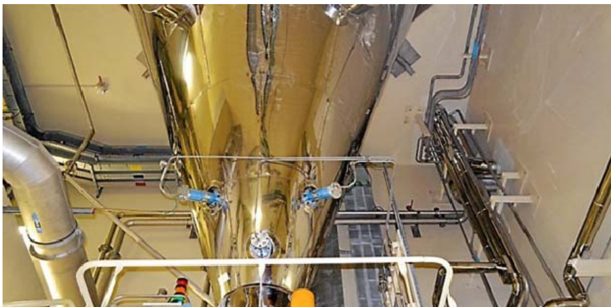
Réacteur ISOFLASH de Malvésí - dénitrification thermique - production d'oxyde d'uranium
